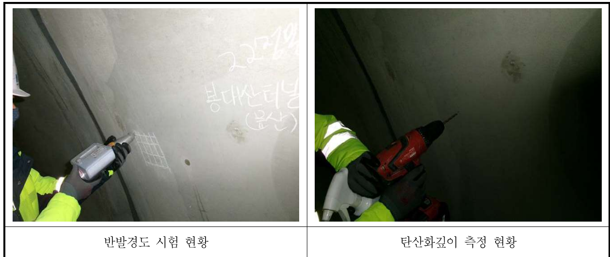
【사진 1.4.1】 콘크리트 내구성조사 현황
