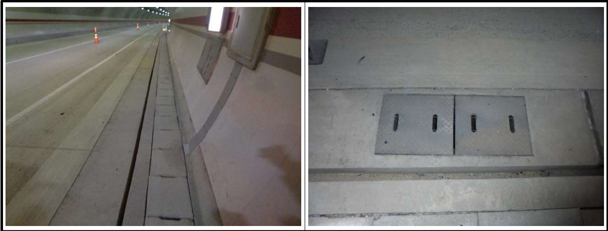
【사진 1.3.8】 공동구 및 배수시설 전경
