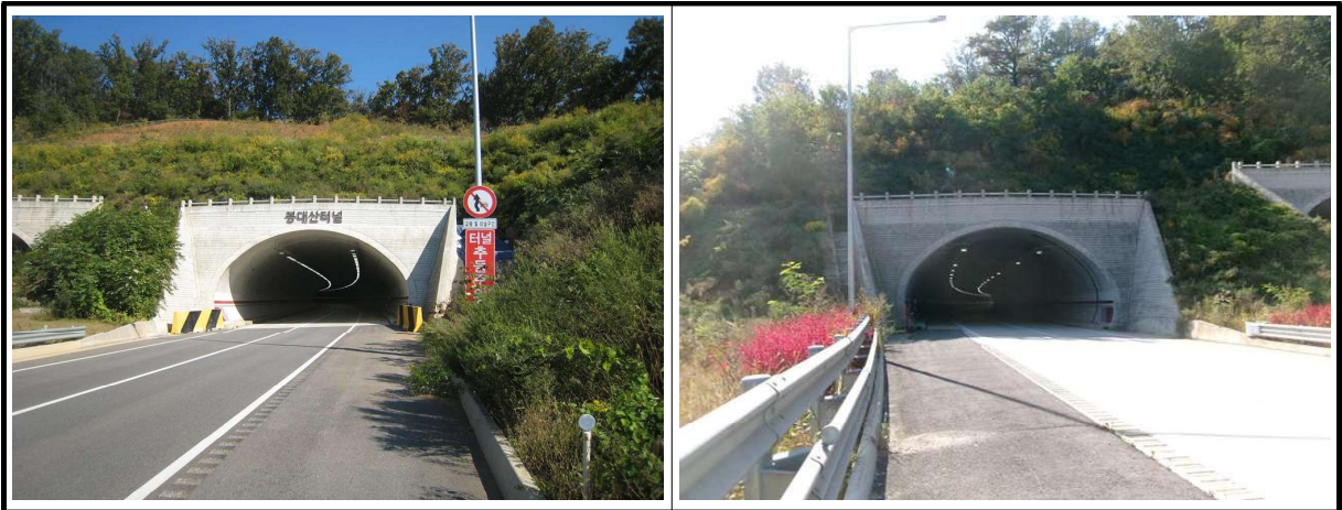
【사진 1.3.18】 갭문 전경
