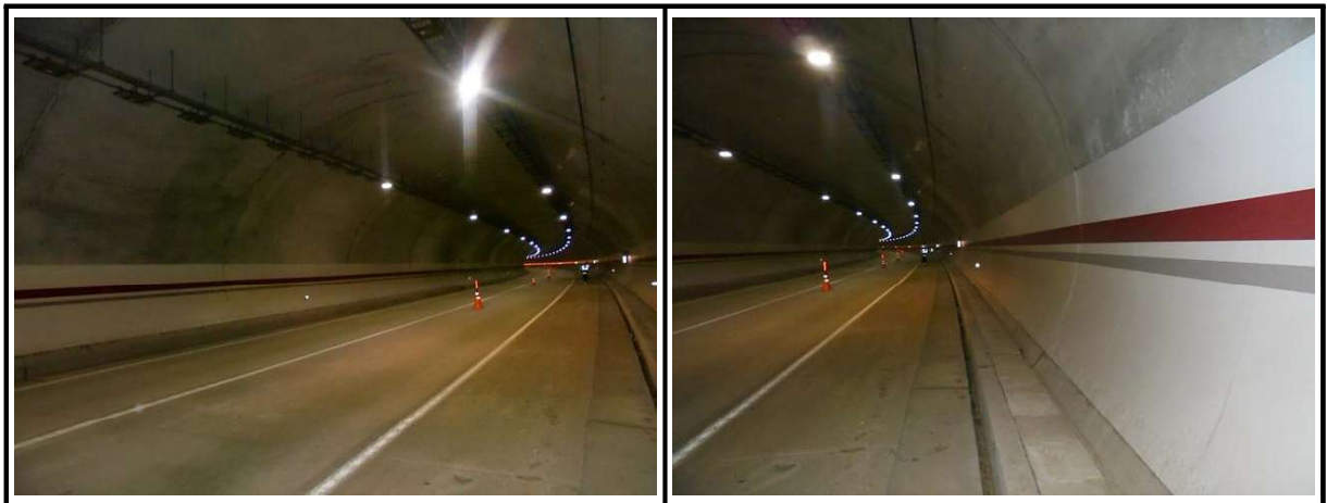
【사진 1.3.16】 라이닝 측벽부 전경
