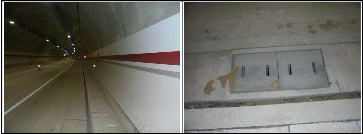
【사진 1.3.21】 공동구 및 배수시설 전경
