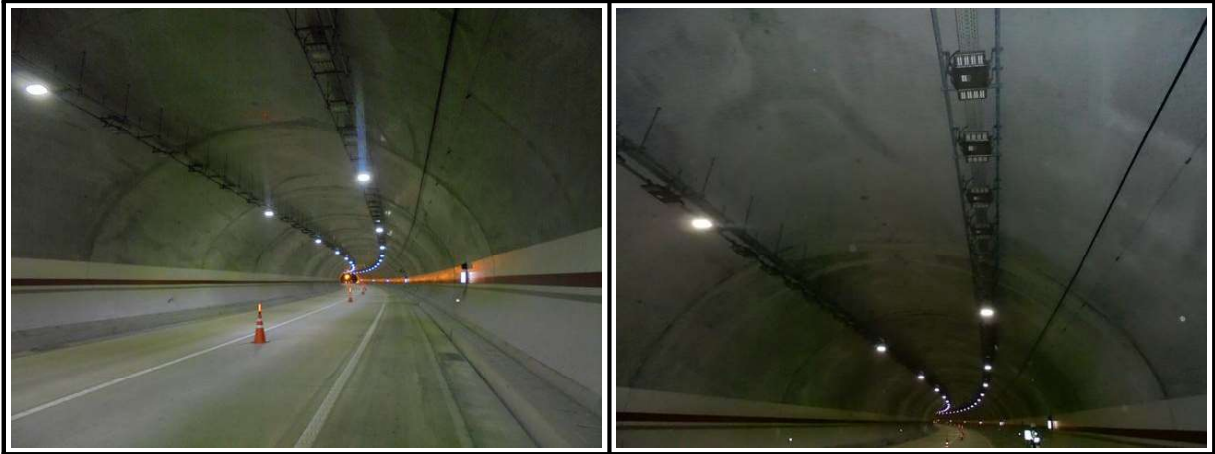
【사진 1.3.14】 라이닝 천단부 전경
