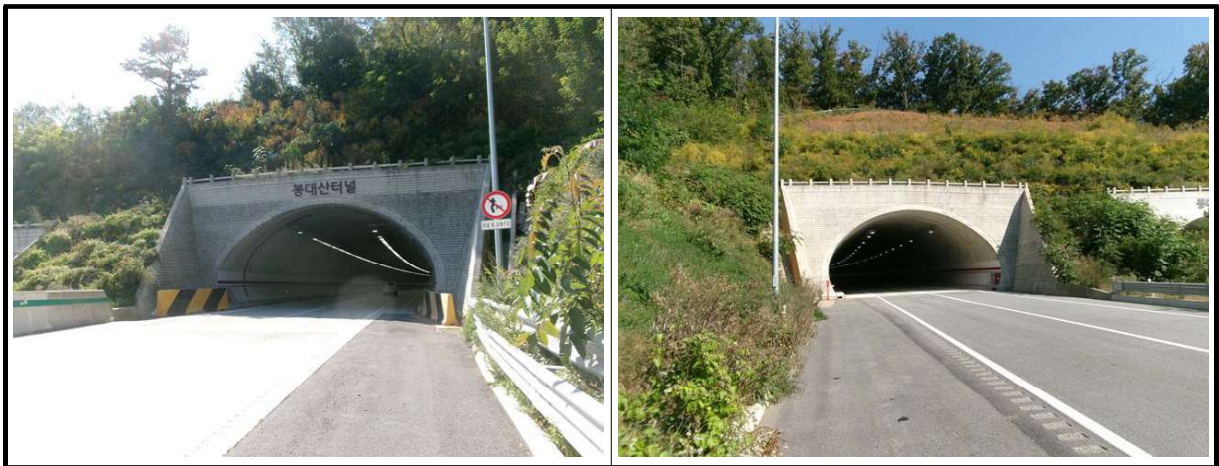
【사진 1.3.5】 갭문 전경
