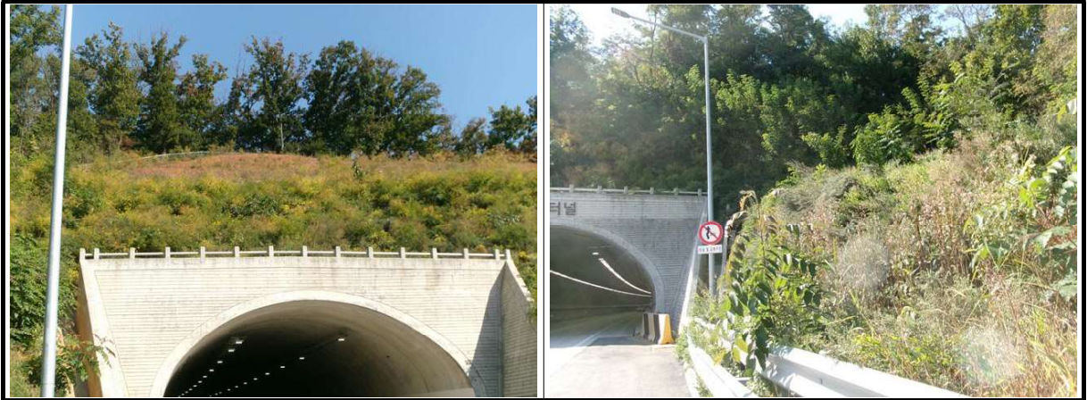
【사진 1.3.7】 사면 전경
