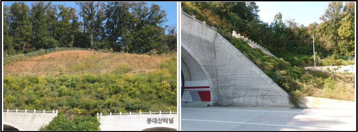
【사진 1.3.20】 사면 전경
