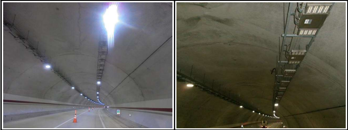
【사진 1.3.1】 라이닝 천단부 전경
