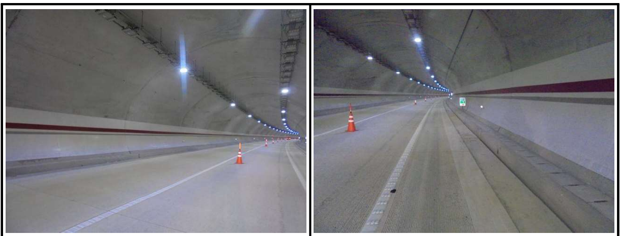
【사진 1.3.3】 라이닝 측벽부 전경
